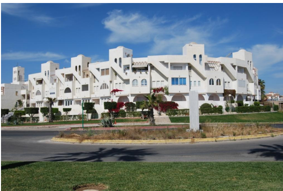
Vista general desde la Ctra.del Puerto.
