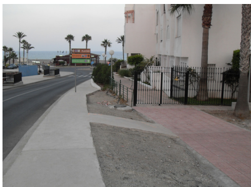
Vista del cerramiento exterior existente que impide el paso al interior del conjunto residencial desde el paseo del Malecón..
