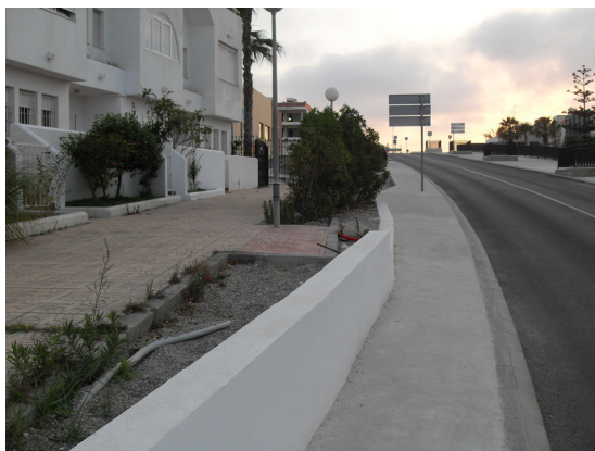
En la imagen se distingue el murete que delimita la zona privada de la comunidad, situada a distinto nivel que la nueva acera perimetral.
