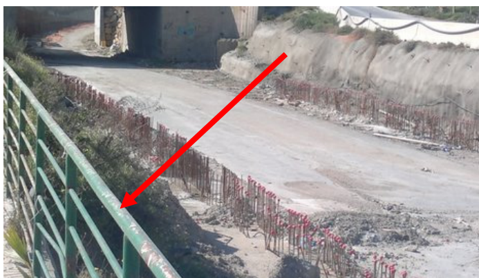
Vista de los tramos de barandilla que delimitaba las la parte privada que permanecieron durante la ejecución de las obras de soterramiento del acceso al puerto.
