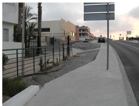
Vista de la nueva acera que garantiza la continuidad del tránsito peatonal y del vallado que impide el paso al interior de la urbanización privada.
