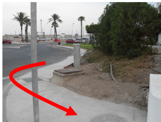
Punto de conexión entre la acera existente y la nueva acera que permite la continuidad peatonal entre el paseo marítimo y el paseo del Malecón.
