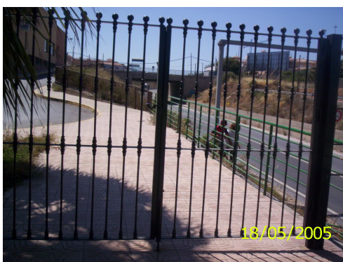
Vista del encuentro del vallado exterior del complejo residencial con la carretera de acceso al puerto y que impide el acceso al interior de la urbanización.
